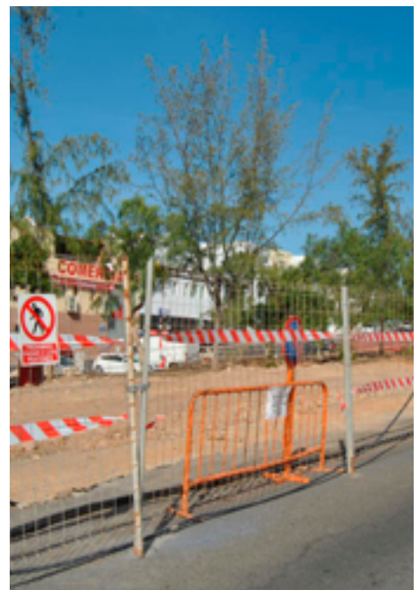
Construcción de la nueva zona de aparcamientos en la zona industrial de El Tablero, con más de 40 plazas de estacionamiento.
