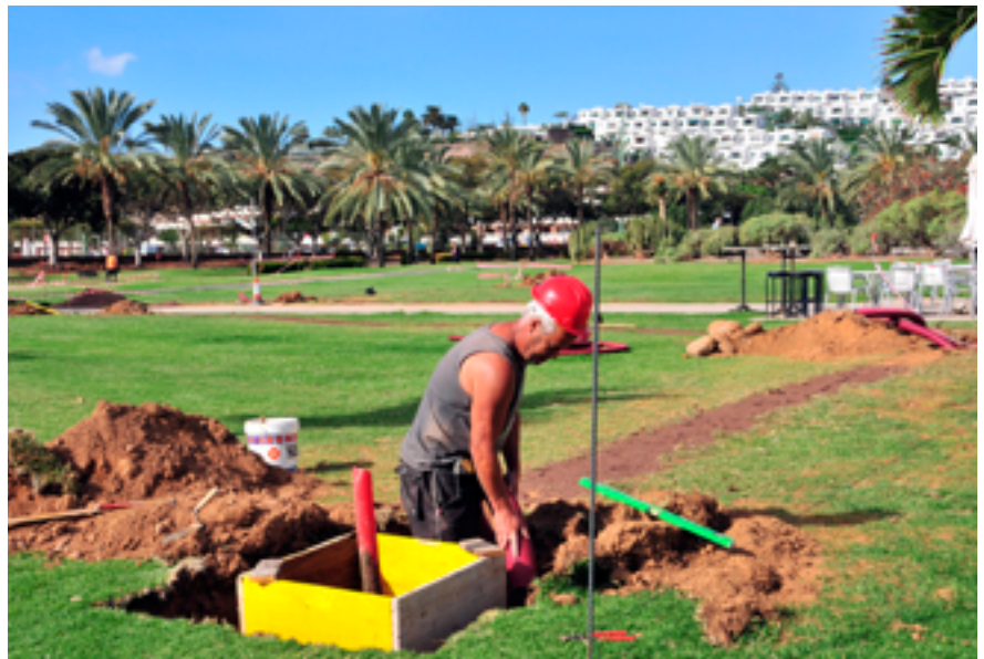
El alumbrado de varios parques del municipio ha sido mejorado gracias al esfuerzo del equipo de gobierno AV-PP. En la imagen, la mejora del tendido en el Parque Sur.
