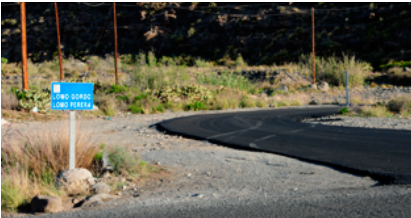
El acceso a Lomo Gordo y Lomo Perera también se incluyó por el Ayuntamiento entre las necesidades, para mejorar las condiciones de los vecinos.
