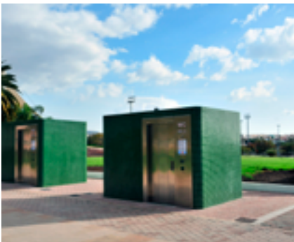
Nuevos baños automatizados en el Parque Urbano del Sur. Éstos disponen de un tiempo máximo de uso y un sistema de lavado interno automático.
