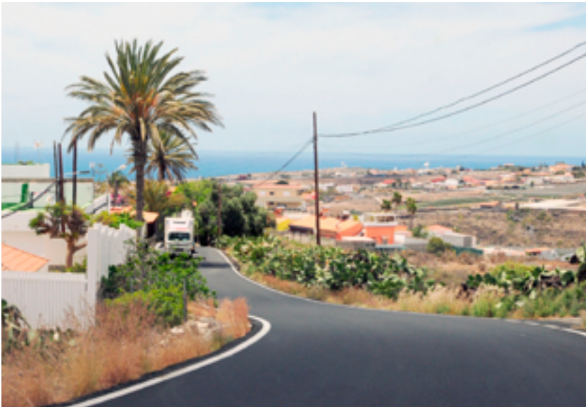
Montaña La Data vio notablemente mejorado el firme de su carretera de acceso con la nueva obra de asfaltado.
