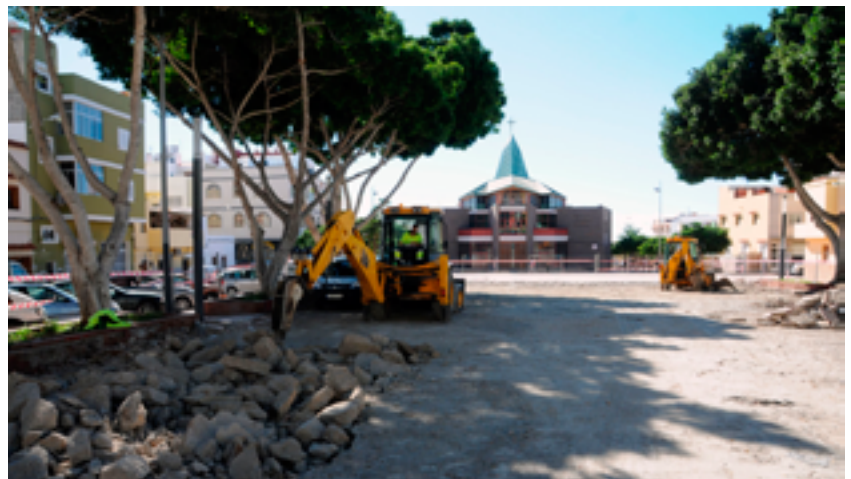
Remodelación completa en la Plaza de El Tablero, que ha sido ejecutada en varias fases.
