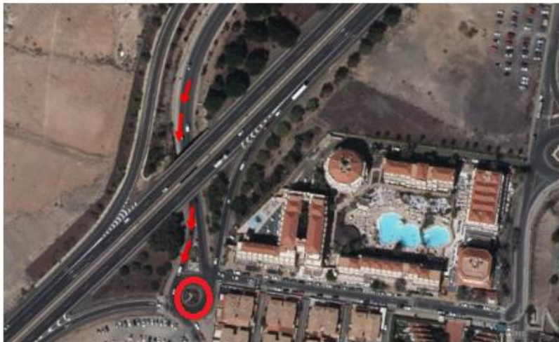
Ilustración 12.- Acceso desde El Tablero a la glorieta GC-1 incluida en el ámbito de estudio. Fuente: elaboración propia a partir de visor IDE Canarias.
