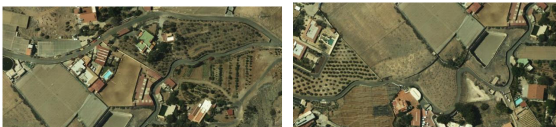
- Estado de desarrollo de la urbanización. Imágenes aéreas de 20/05/2020. Fuente: IDE Canarias.
